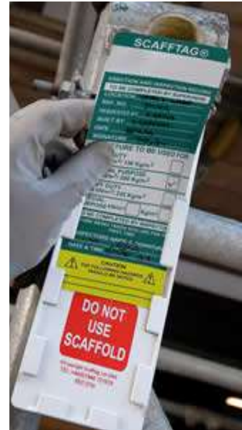
CERTIFICACION DE EQUIPOS
