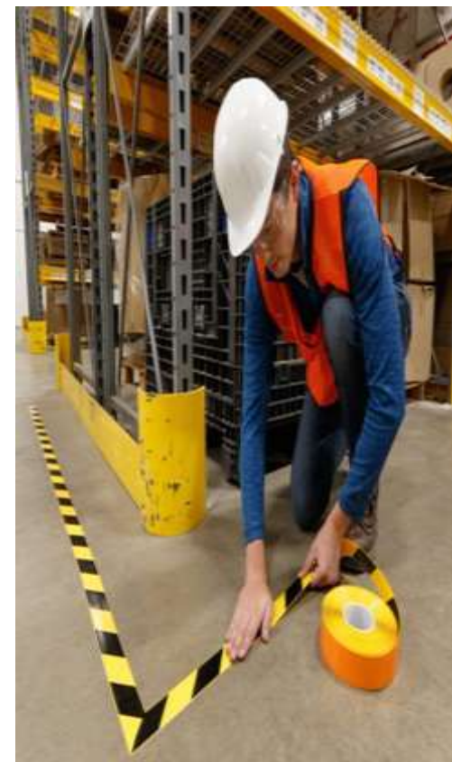
MARCACION DE PISOS
